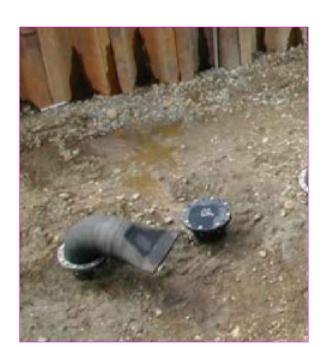
O4 Diffuser Valve for Effluent Discharge to Water Body NTS
