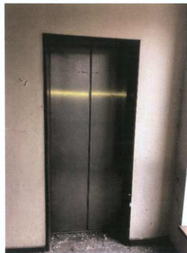
Plate 493: Lift lobby — Door 2
