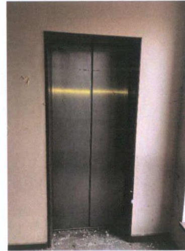
Plate 493: Lift lobby — Door 2
